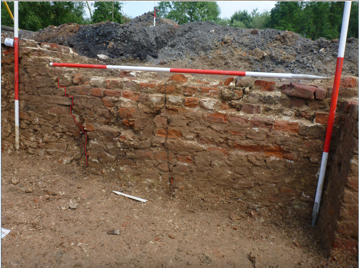
Figuur 7.7. In het zuidelijke deel van de oostelijke torenmuur wijkt het metselwerk af ten opzichte van de rest van het poortgebouw (boven). Het metselwerk bestaat hier uit een uit een soort kistwerk met aan de buitenzijden een halve steen metselwerk. Het verschil in metselwerk tekent zich ook in het aanzicht van de muur af (beneden).
