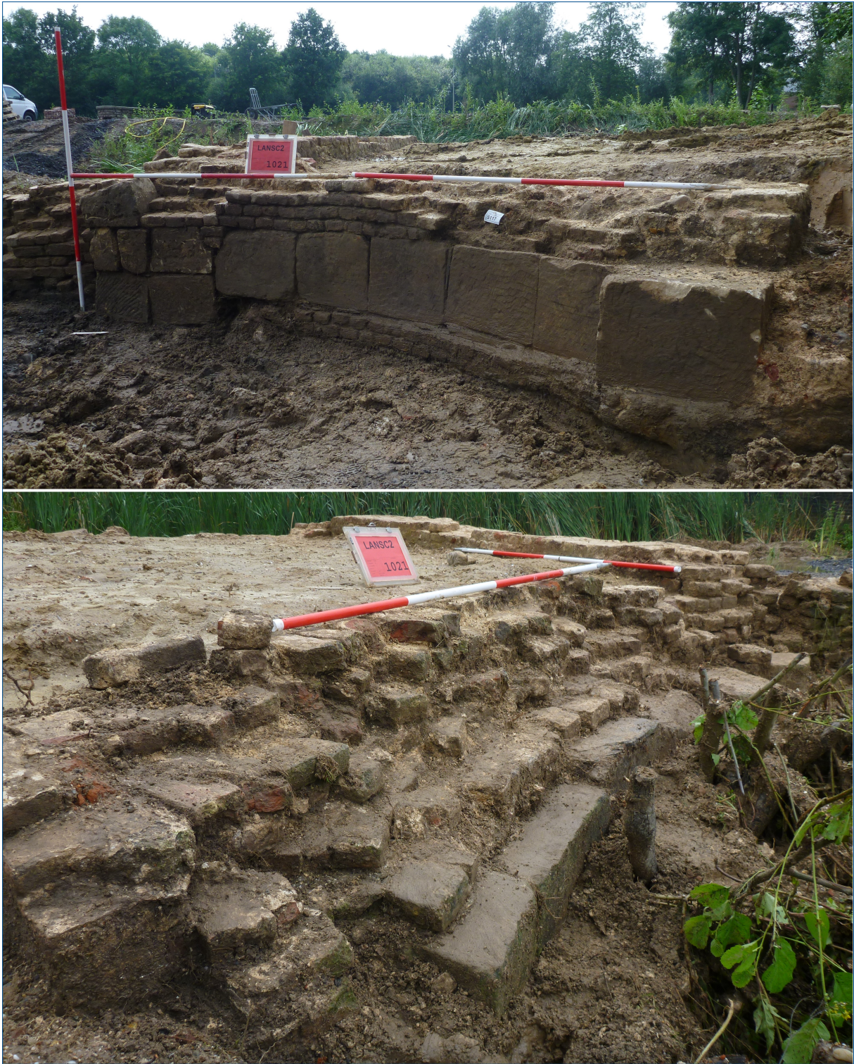
Figuur 8.2. De oostelijke zijmuur (boven) en westelijke zijmuur (beneden) van het landhoofd.
